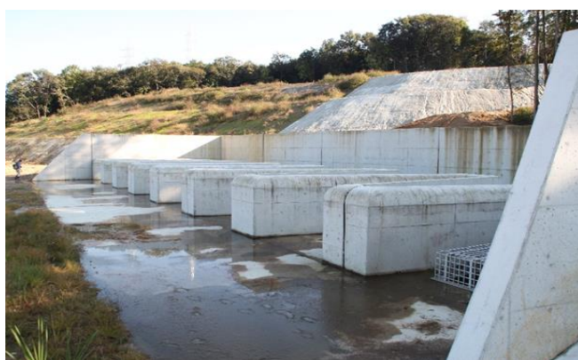
車両基地用に造られた貯水池の越流堰
