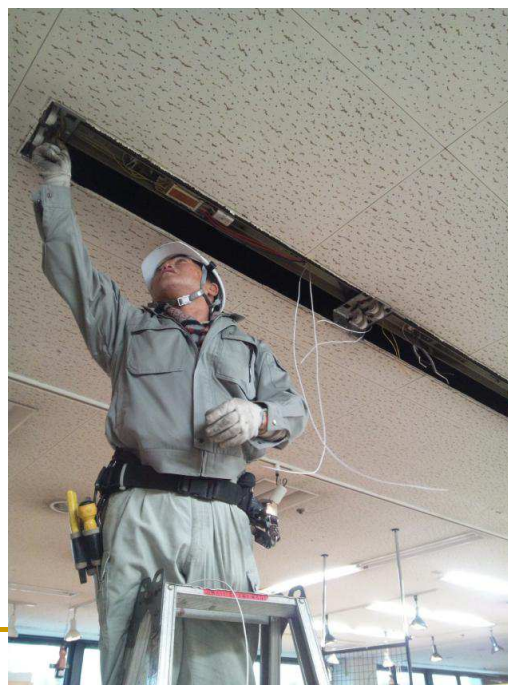
LED切替工事の様子
