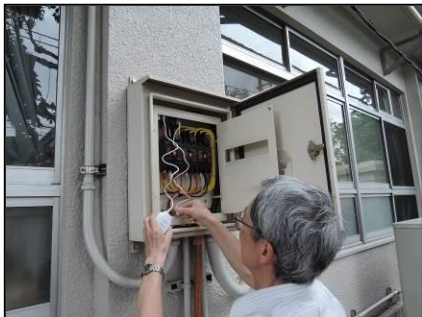
電力測定器を取り付ける
