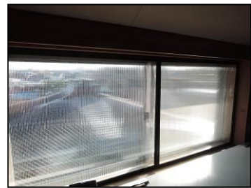
DIY による内窓の取付実験
