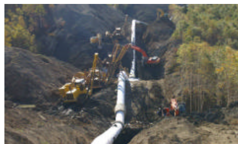
<サハリン 2 パイプライン敷設工事>
