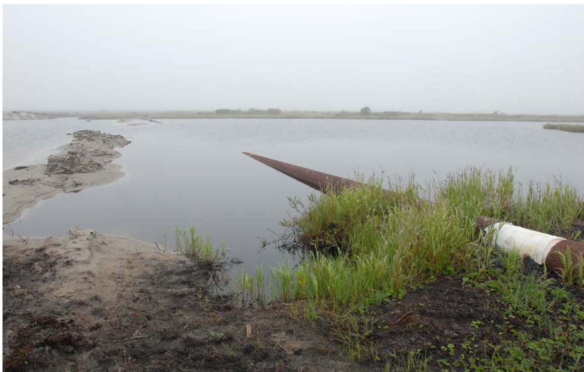
ハマシギ固有亜種などの生息する脆弱な湿原を横断するパイプライン 4本のパイプはいくつもの小さな湖沼を横断する。凍結と解凍を繰り返す脆弱な地形はパイプラインは、地震などの際に破断する恐れがあると思われる。生物に与える影響は甚大となるであろう。
