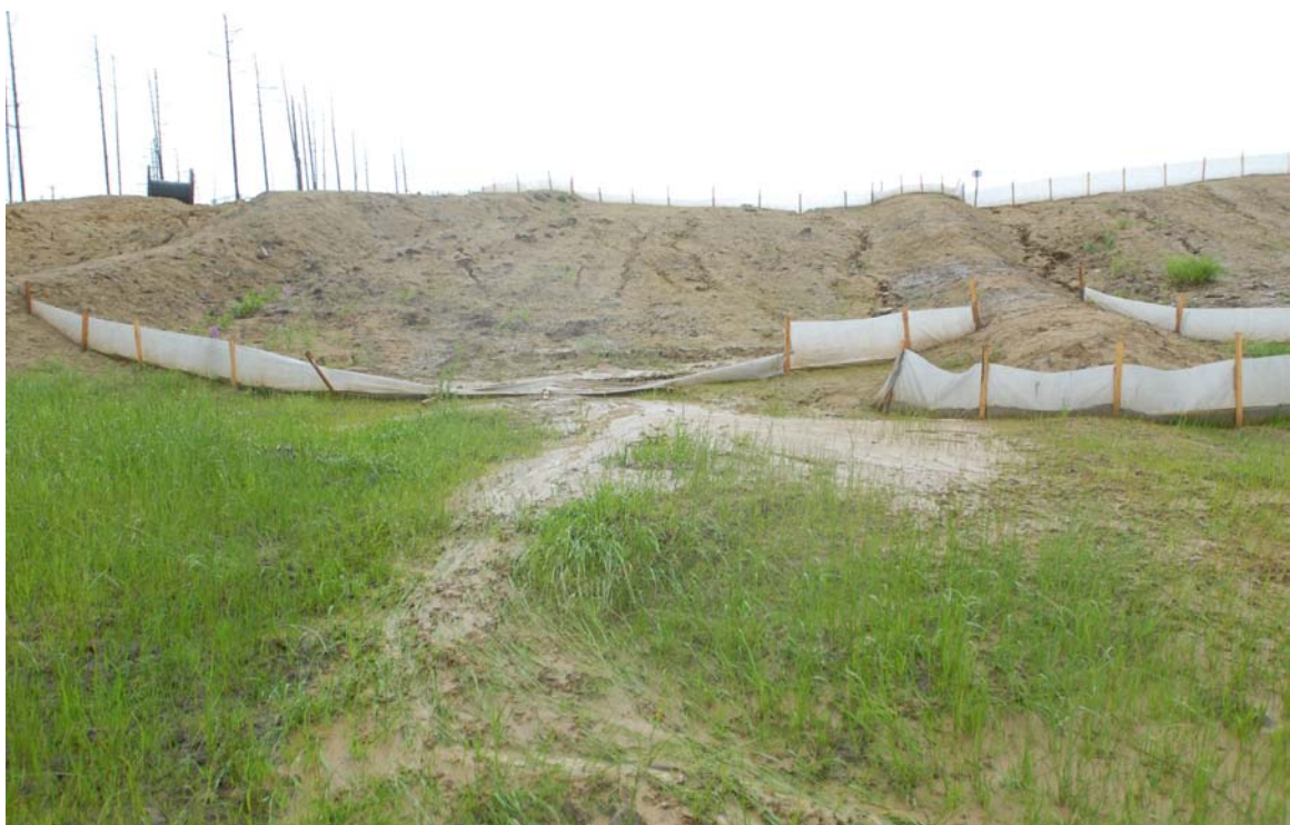
オオワシ繁殖地の直近のサケマス遡上河川で認められる土砂流入 斜面に対する土砂の流出防止策は全く機能していない。
