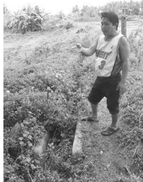
「ダム建設後、13 年経っても未完成の水路。この先の農地に灌漑用水は届かない。」と嘆く農民代表（フィリピン・ボホール灌漑事業）
